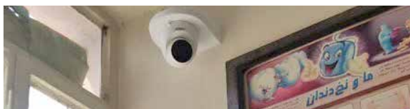
هدایی یک دستگاه سونی کید - نصب دوربین مداربسته در خانه بهداشت
